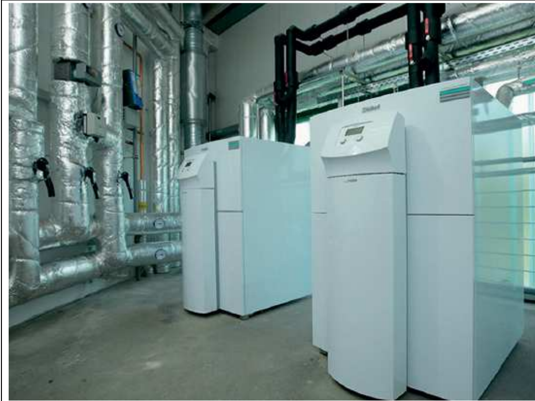
Központi fűtési rendszer kaszkád kialakítása
